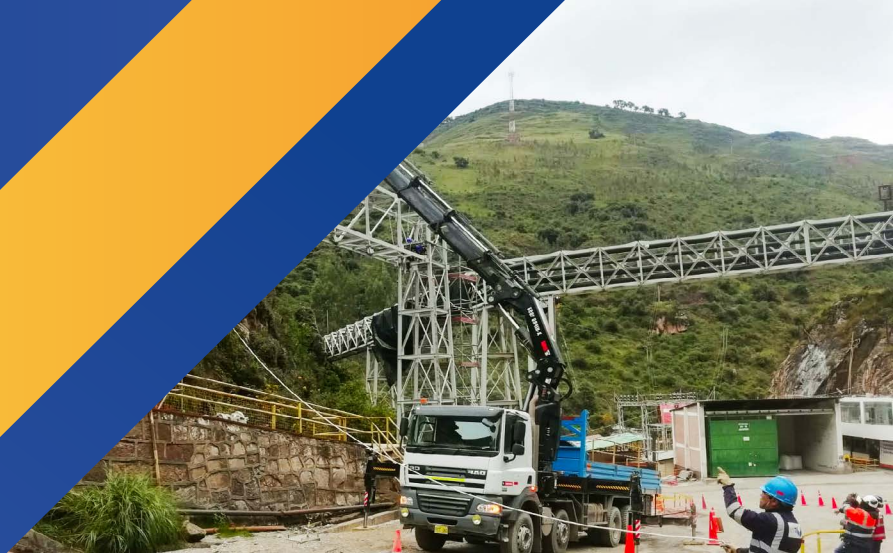
IZAJE DE PIPE RACK PARA TUBERÍA HDPE DE \Phi 14
