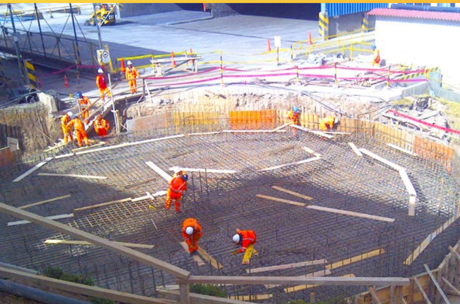
COLOCADO DE CONCRETO EN LA BASE DE CELDA OK 100
