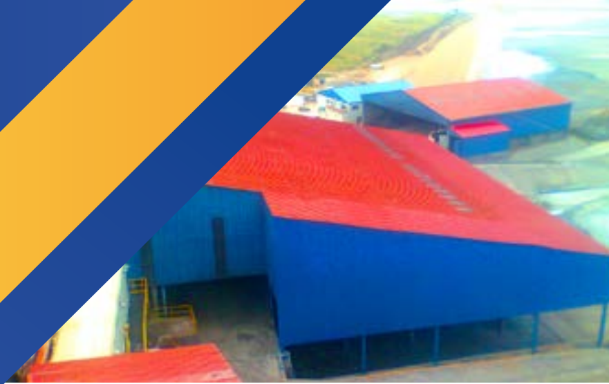
AMPLIACIÓN DE NAVE DE CANCHA DE CONCENTRADO
