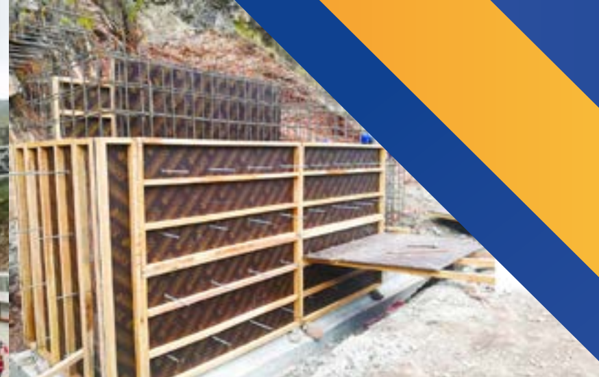
ENCOFRADO PARA CAJA DISIPADORA
