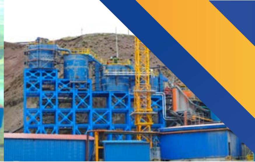
FABRICACIÓN Y MONTAJE DE SOPORTE METÁLICO PARA CELDAS RCS100-RCS50-RCS30
