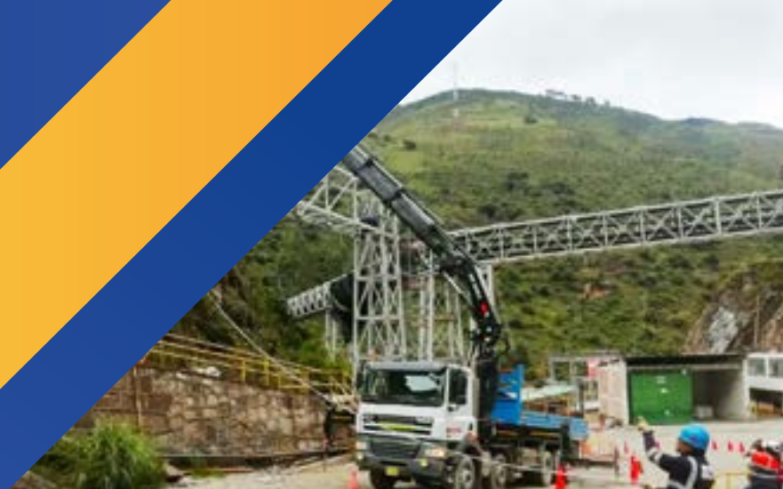
IZAJE DE PIPE RACK PARA TUBERÍA HDPE DE \Phi 14
